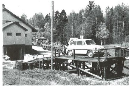
Korjaamon ulkopuolelle oli rakennettu "rasvamonttu".
